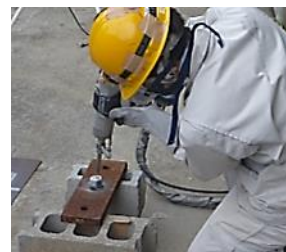
写真-2 CS 施工風景
