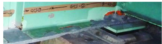
写真-4 施工後の桁端部
