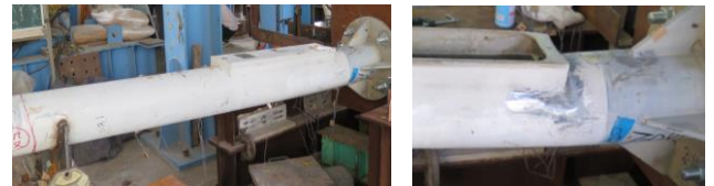
リブ有の耐荷力試験終了時全体と開口部拡大
