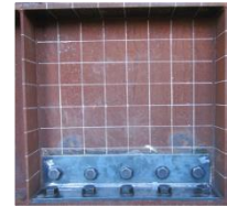
写真3 当て板ボルト補修
