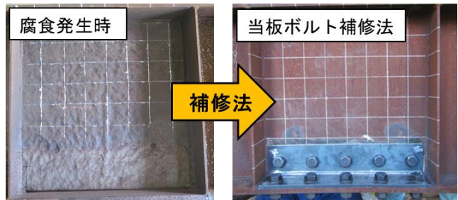
図 1-1 当板ボルト補修法
