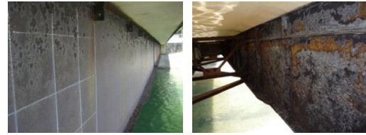
写真 1-1 鋼 I 桁橋内外面 (左から外面, 内面)
