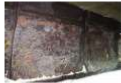
写真1 鋼桁端部の腐食事例 写真2 摩擦接合継手試験体
