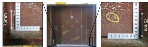
(a) 腐食試験体
