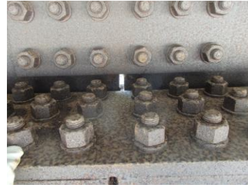
写真-1 高力ボルトを用いた摩擦接合
