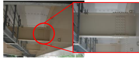
写真1 部材交差部、狭隘部
