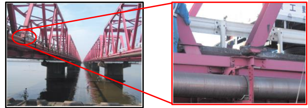
写真-1 下路トラス橋
