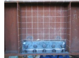
写真 1-2 当板ボルト工法
