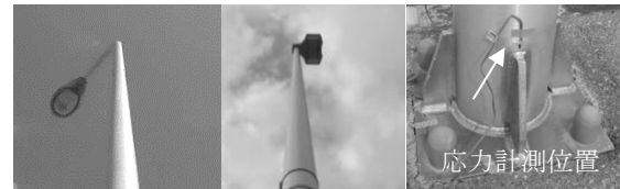
(a)モヤシ形(b)直線形(c)基部 図-4 照明柱構造と応力計測位置
