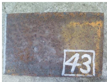
写真1 試験体腐食状況 (錆厚: 126.8 \mu m)
