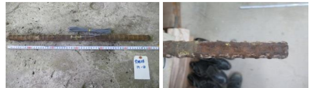
写真 - 1. 腐食した鉄筋（引張強度試験体）
