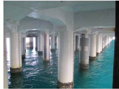
図1.ライニング材加工された橋梁鋼管
