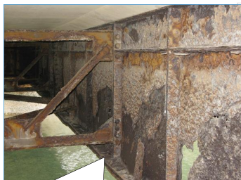
鋼桁間は腐食が進行しやすい
