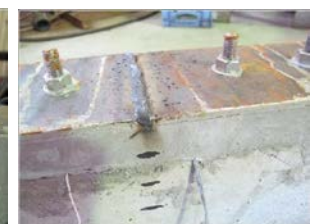
写真 5 鋼板溶接後
