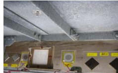
写真 2 鋼板試験片設置状況
