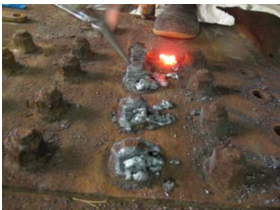
写真 5 軸力計測試験後腐食ボルト
