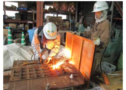
写真3 腐食ボルト軸力計測状況
