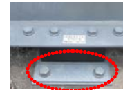
写真3 実際の支承構造
